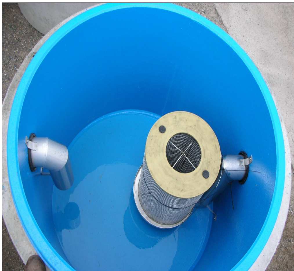
Particolari interni dell'impianto NEUTRAkap
