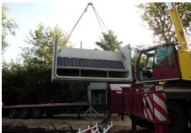
Esempi di posa sedimentatori lamellari VIATUB
