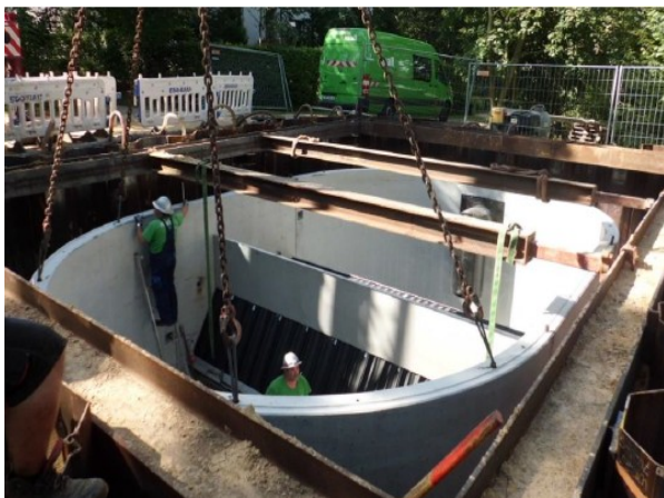
Esempi di posa sedimentatori lamellari VIATUB
